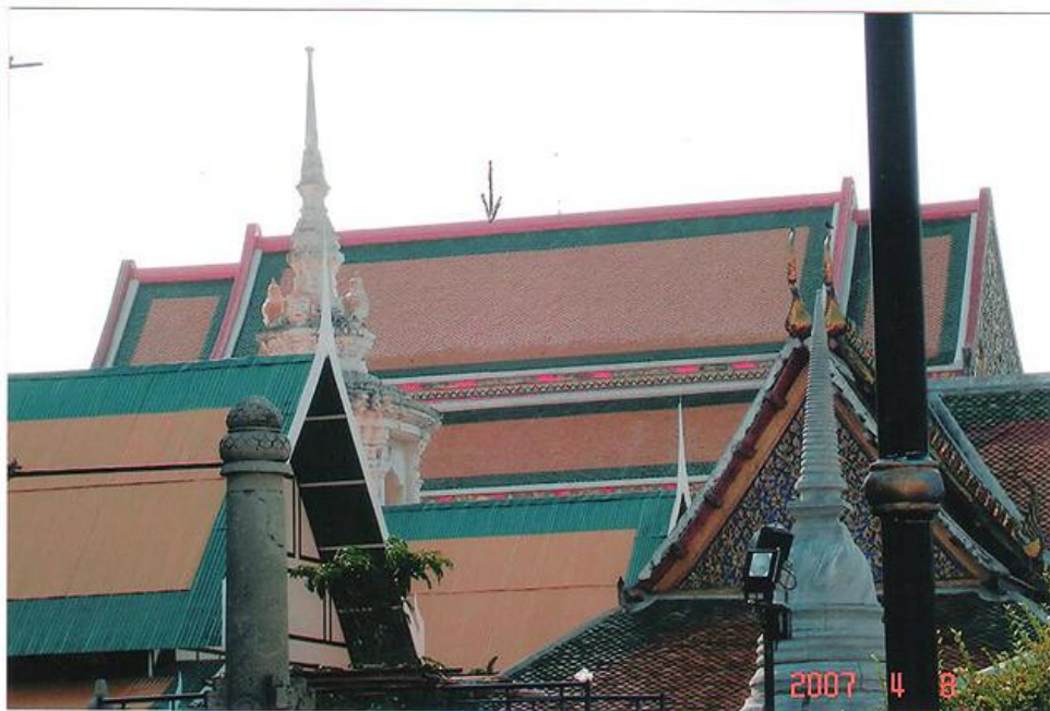
สีหลังคาวัด ก่อนและหลังการบูรณะ เป็นการก่อสร้างโดยไม่ได้รับอนุญาตจากกรมศิลปากร
