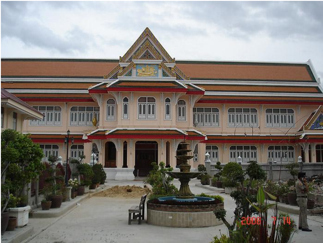
โรงเรียนพระปริยัติธรรมที่สร้างใหม่หลังจากการรื้อถอนมรดกสถาปัตยกรรมเดิมของวัดออก
