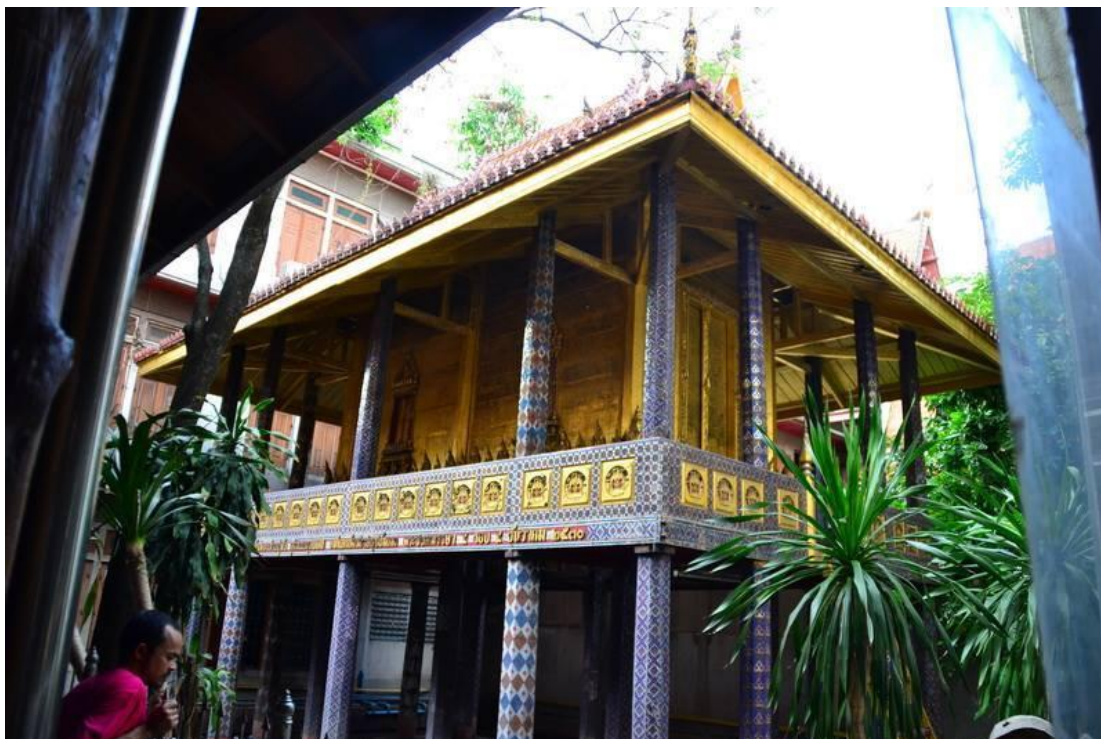
การซ่อมแซมที่ทำให้รูปแบบอาคารที่ทรงคุณค่าแบบดั้งเดิมผิดเพี้ยนไป หอไตรวัดปากน้ำ
