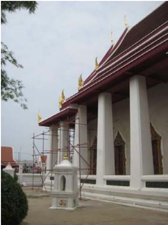
สภาพด้านนอกของพระอุโบสถ และพื้นที่โดยรอบอาคารที่มีการถมระดับพื้นในสูงขึ้น
