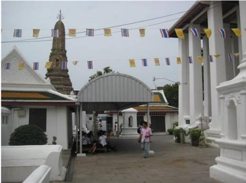
การติดตั้งเต็นท์ถาวร บริเวณด้านข้างอุโบสถ
