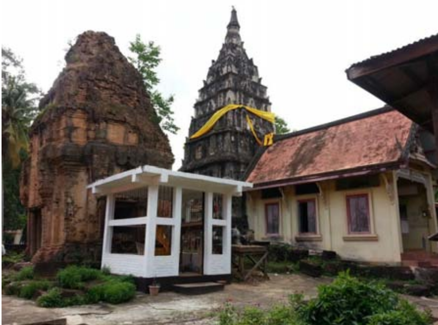
การก่อสร้างอาคารใหม่คร่อม หรือประชิด อาคารโบราณสถาน ที่กุ่งพระโกนา ด้วยต้องการอาศัยความศักดิ์สิทธิ์จากองค์ประกอบที่มีความเก่าแก่
