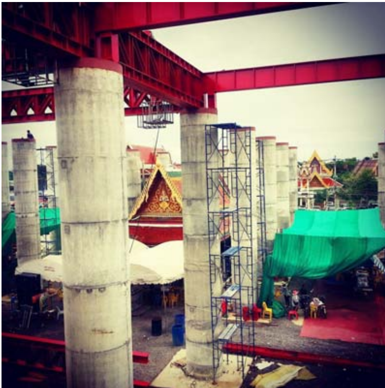
การก่อสร้างอยู่ระหว่างดำเนินการ
