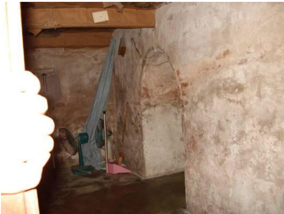
ห้องใต้ดินหลังการซ่อมแซมกุฎิ
