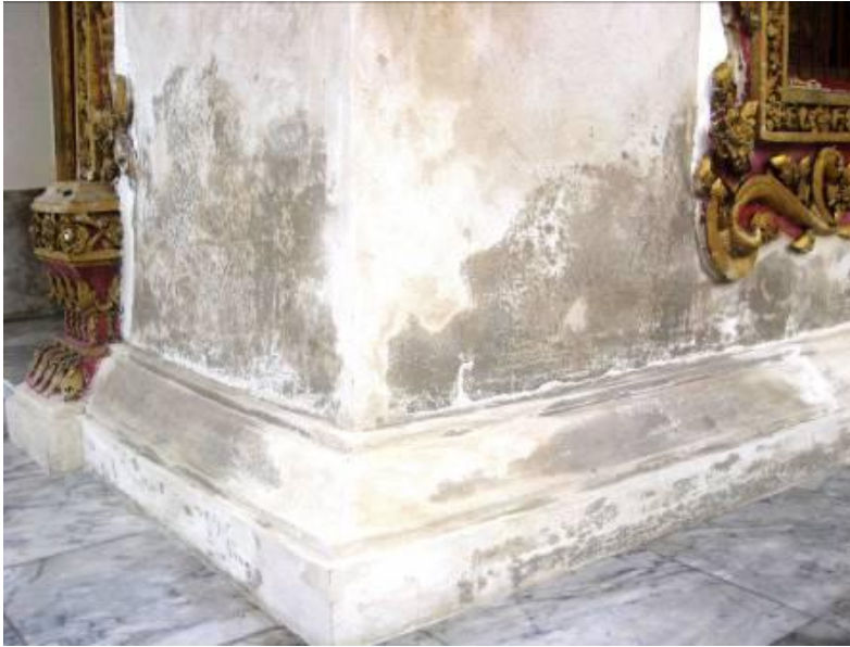
สภาพฐานเสาที่มีความชื้นสะสม
